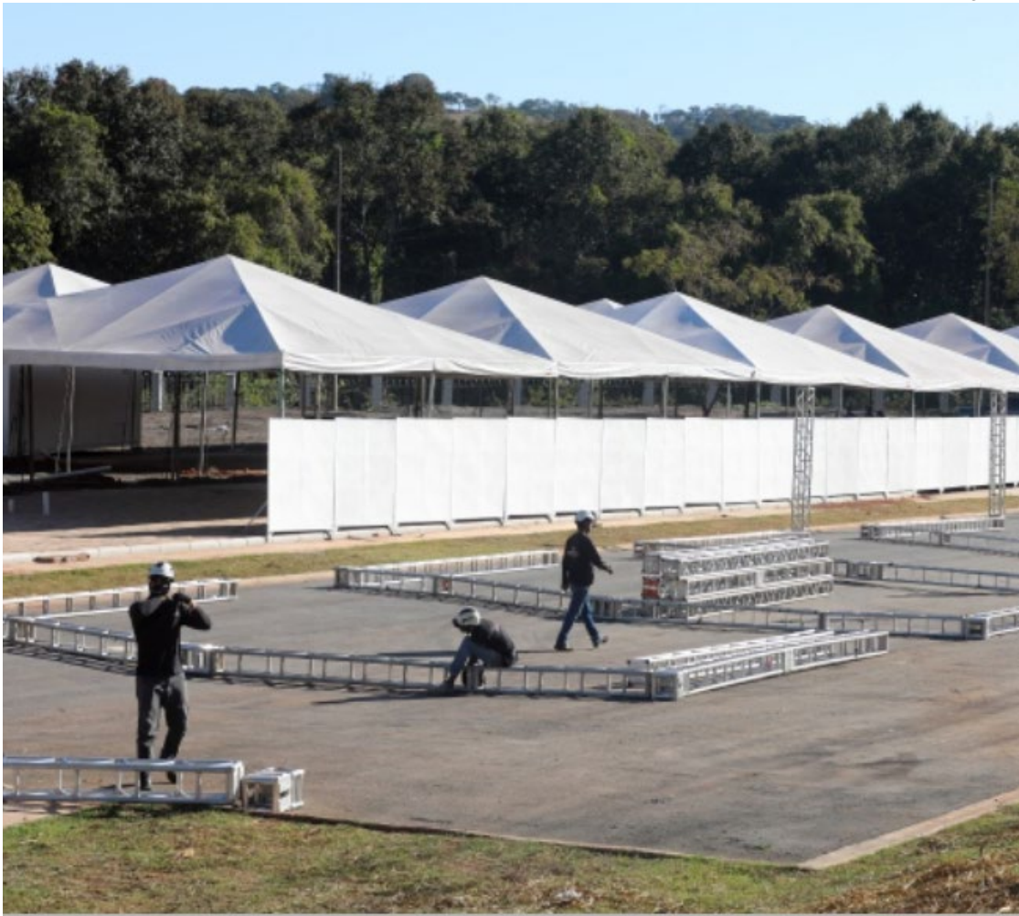
Estrutura do Centro de Apoio ao Romeiro de Trindade começa a surgir na rodovia que levará fiéis
